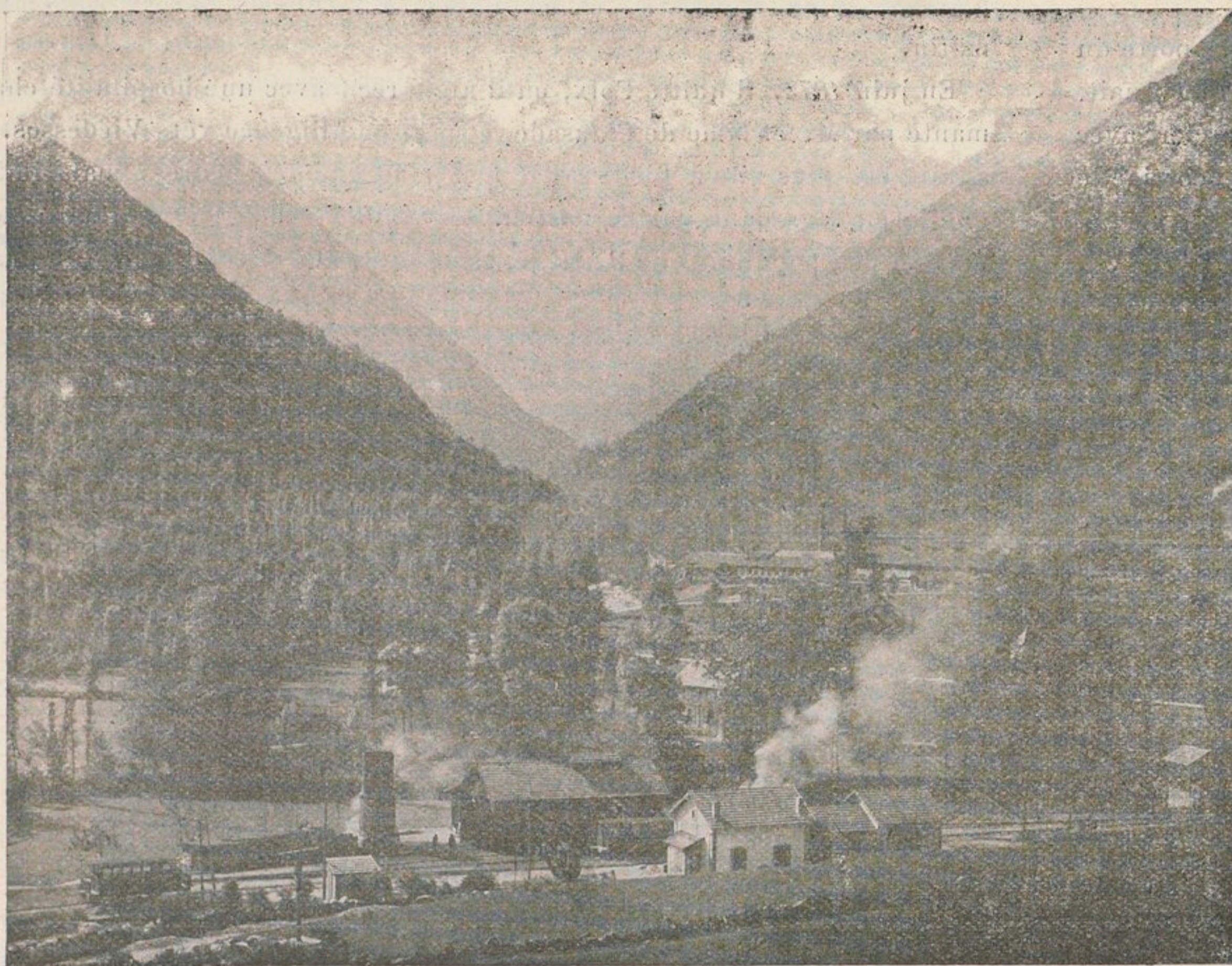
AUZAT — La Gare, les Usines, le Montcalm.
